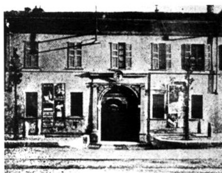
Fronte dell'edificio cinquecentesco demolito
